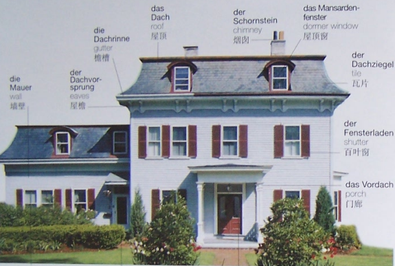
das Fenster window 窗户 der Anbau extension (建筑物)增建部分 der Weg path 小径 die Haustür front door 前门 die Dachrinne gutter 檐槽 das Dach roof 屋顶 der Schornstein chimney 烟囱 das Mansardenfenster dormer window 屋顶窗 der Dachziegel tile 瓦片 der Fensterladen shutter 百叶窗 das Vordach porch 门廊
