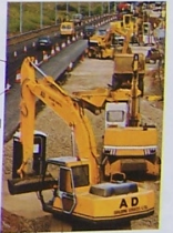
der Pressluftbohrer pneumatic drill 风钻 der Neubelag resurfacing 重铺路面 der Bagger mechanical digger 挖掘机
