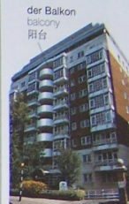
der Balkon balcony 阳台 der Wohnblock block of flats 公寓楼
